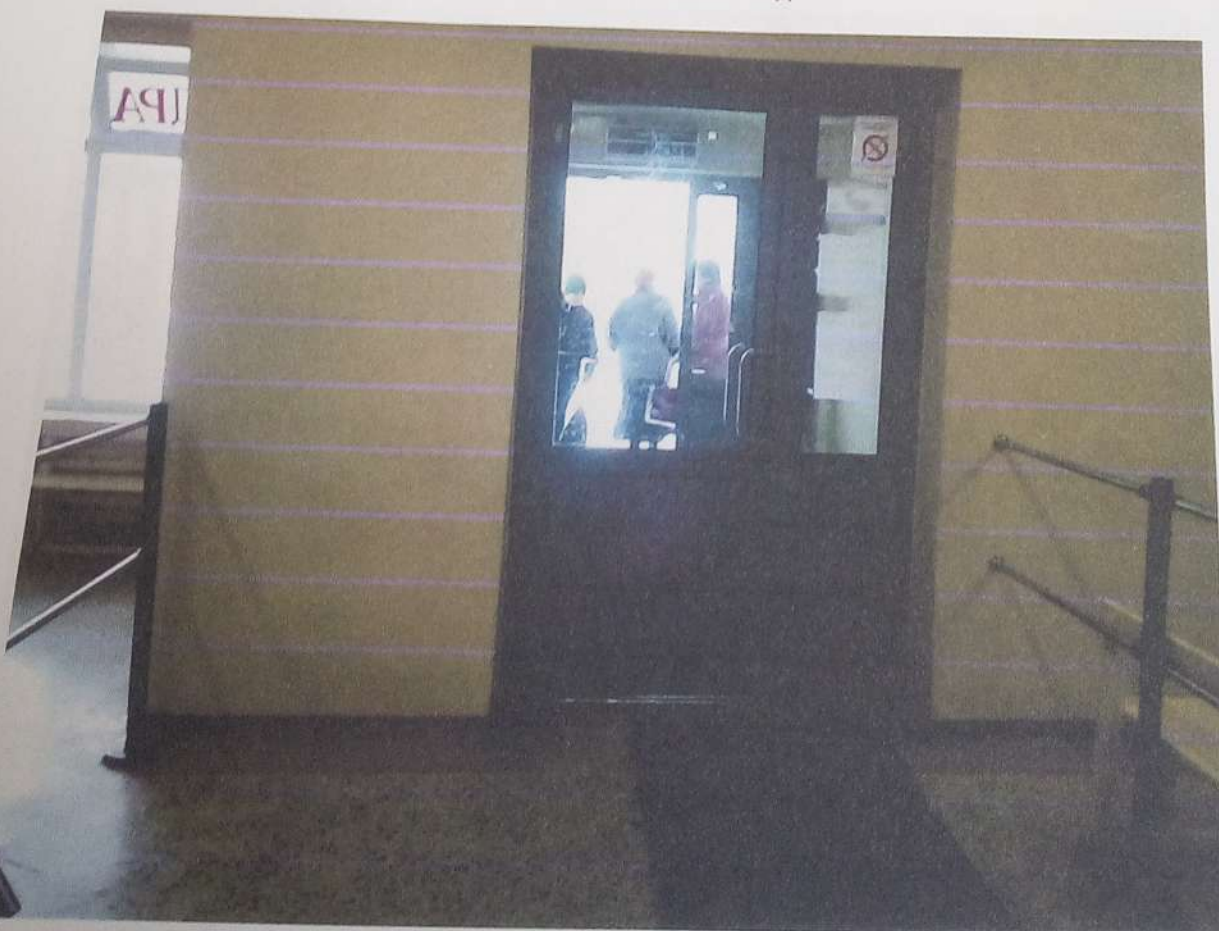
Фото № 6 Главный вход
